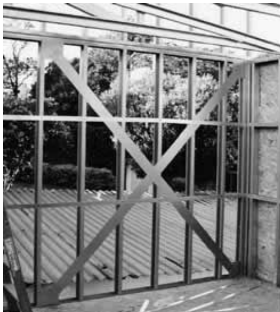
Figura 64 – Contraventamento em “X”
