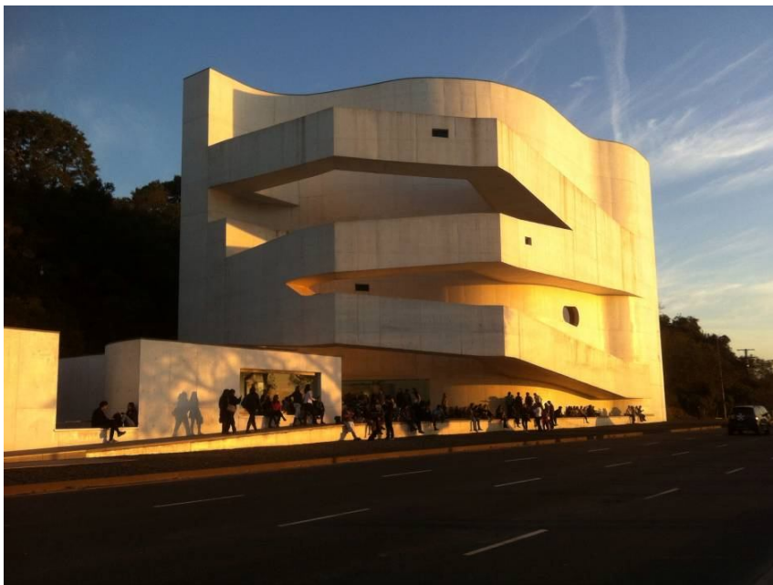
Figura 46 - Fundação Iberê Camargo
