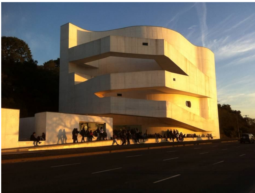
Figura 18 - Fundação Iberê Camargo
