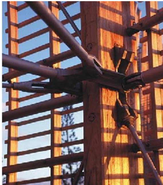
Figura 57 - Método estrutural das cabanas
