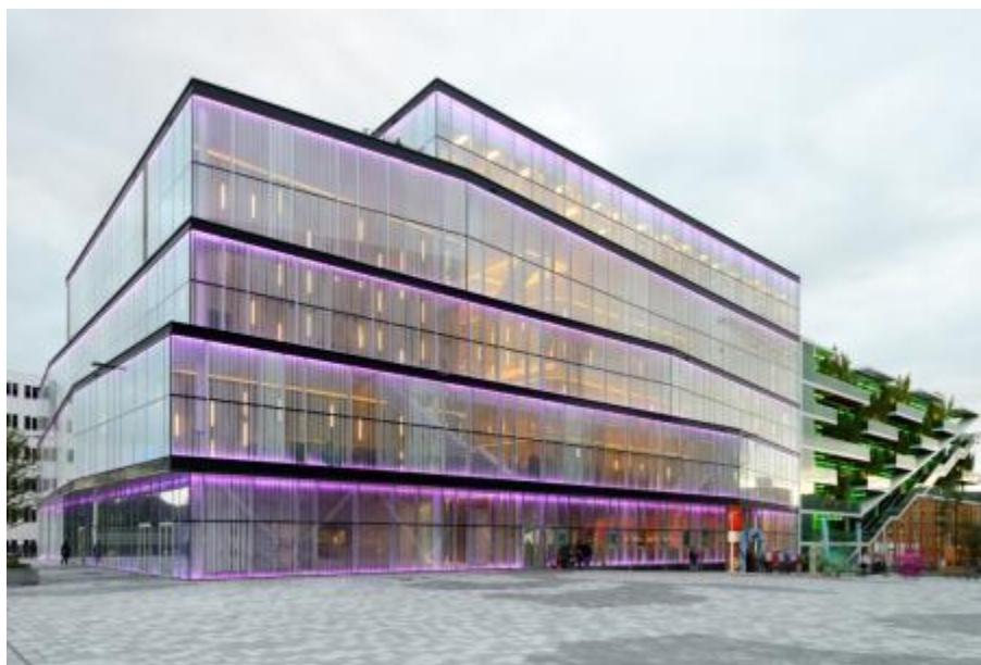
Figura 46 – Prédio de quatro pavimentos.
