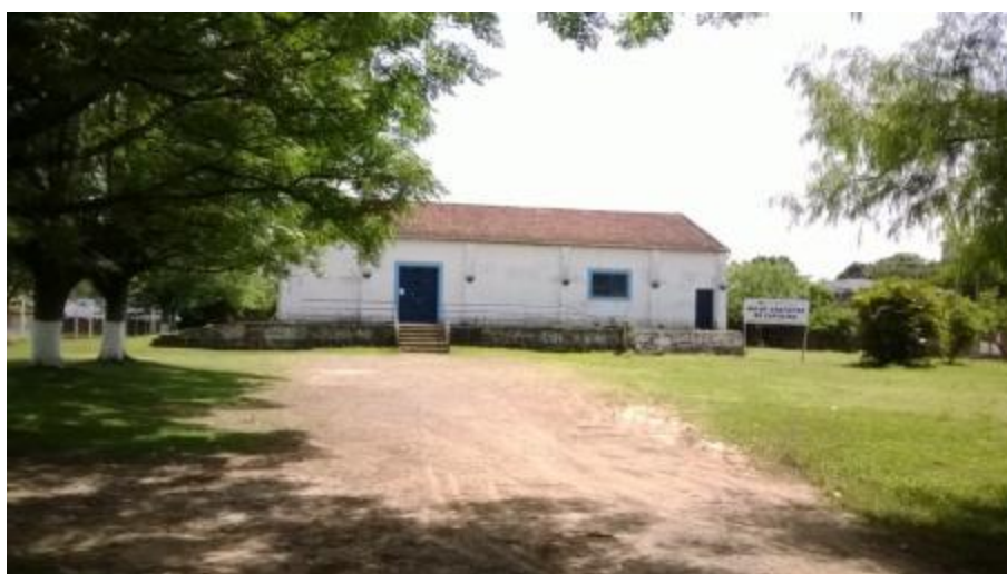
Figura 04 – Depósito da linha ferroviária.
