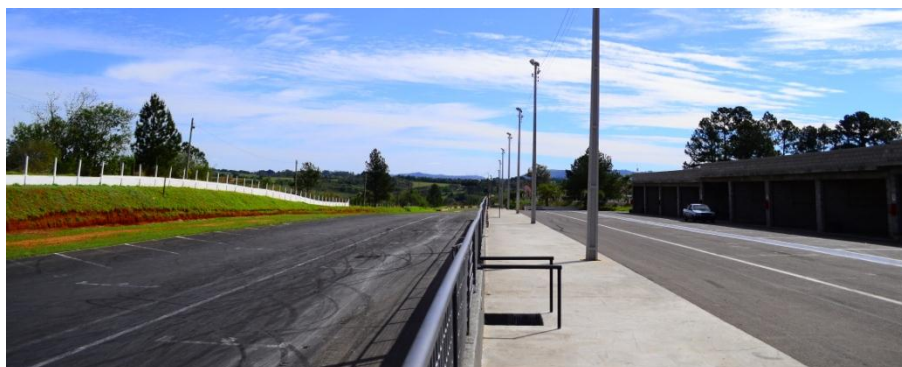
Figura 23 – vista da reta principal e via de acesso aos boxes
