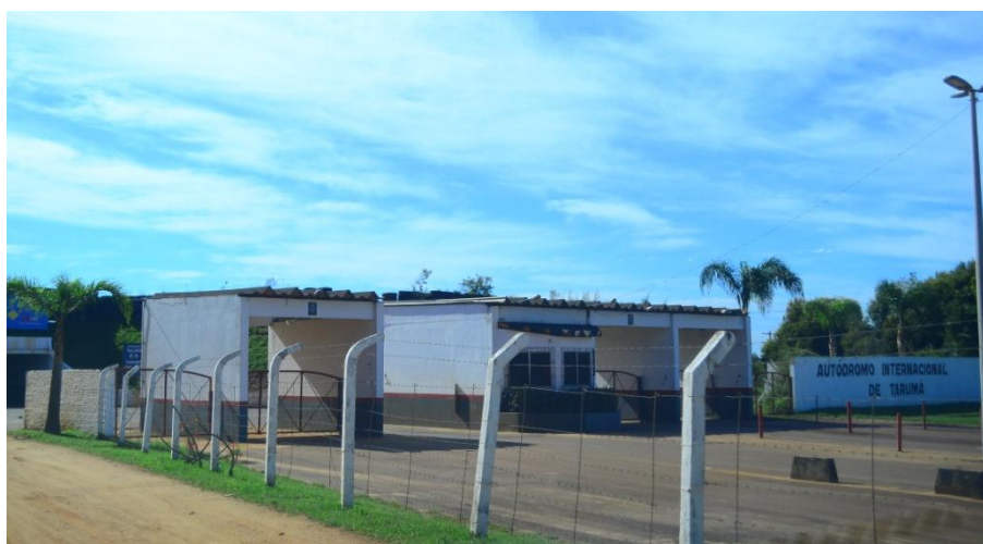
Figura 16 – Pórtico de Acesso
