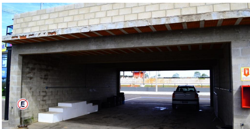
Figura 22 – Vista interna de uma unidade dos boxes
