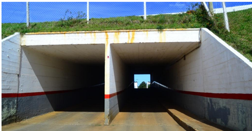
Figura 25 – Túnel de acesso ao centro do autódromo
