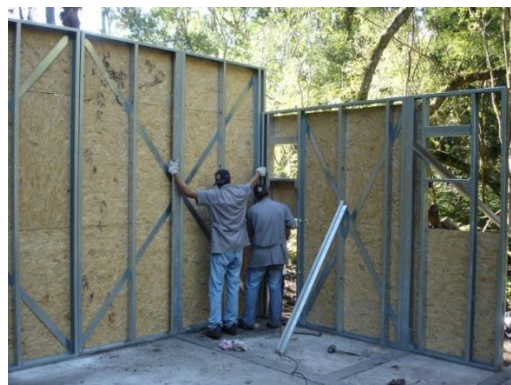
Imagem 45 - Perfis metálicos apoiados na laje, e as placas de OSB sendo fixadas
