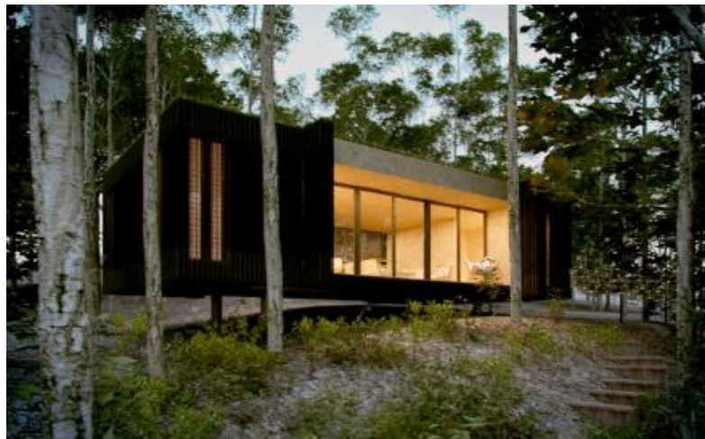
Imagem 57 - Fachada Sudoeste - Refúgio Juquitiba
