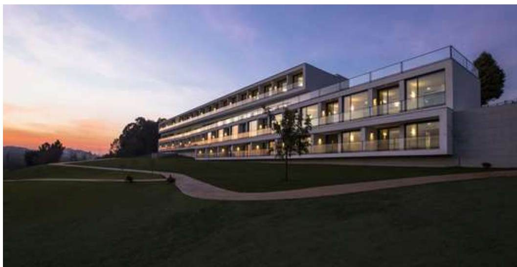
Figura 56 – Fachada sul noturna
