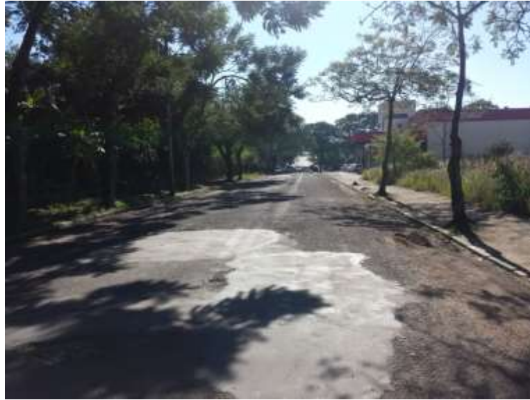
Figura 49 – Vista da Rua Santo Antonio
