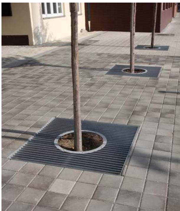
Figura 50 - Referência para marcação do piso
