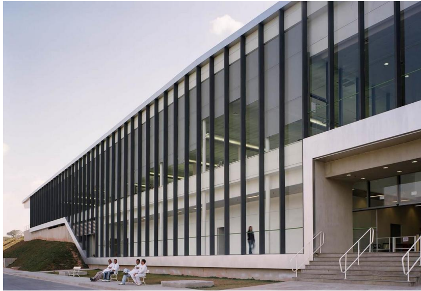
Figura 52 – Fachada principal, setor administrativo
