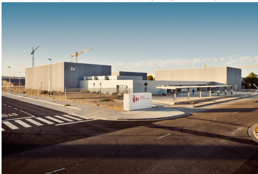
Figura 57 – Vista da Fundação a partir da esquina
