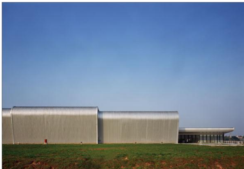
Figura 49 – Pavilhão industrial e setor administrativo
