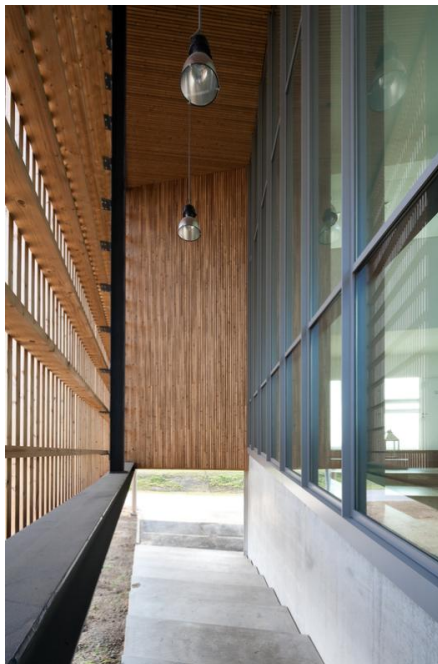
Figura 70 - Escada ao acesso principal
