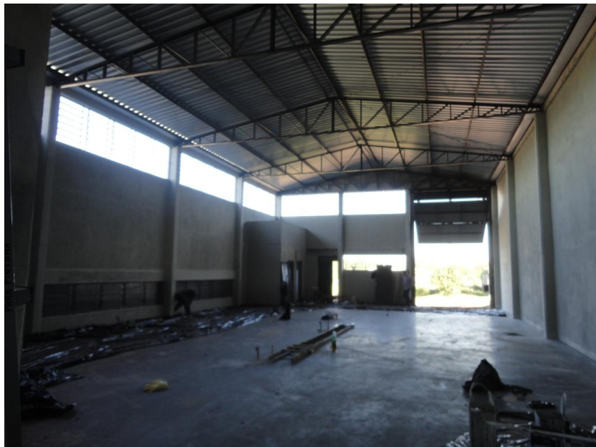
Figura 16 - Expansão do setor de produção (obra em fase final)
