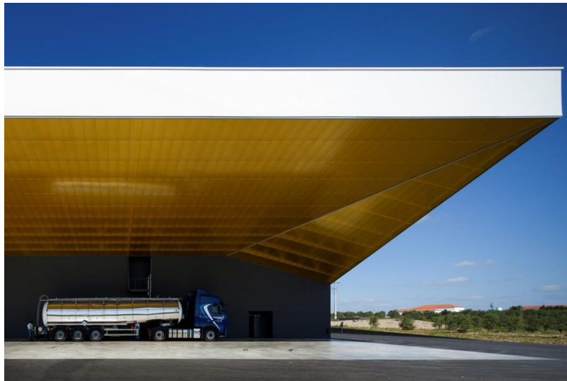
Figura 63: Extremidade que possui o carregamento do produto
