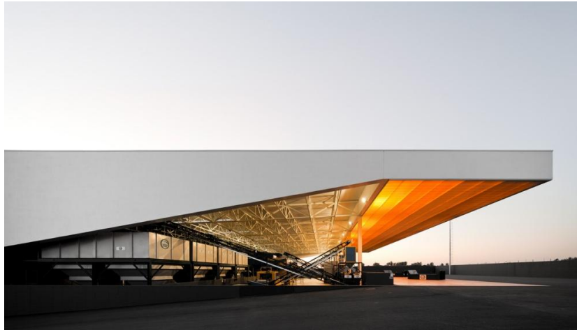
Figura 61: Cobertura em cantilever que abriga as esteiras
