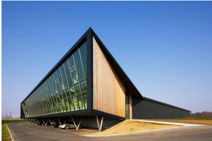
Figura 68 – Estacionamento sob escritórios
