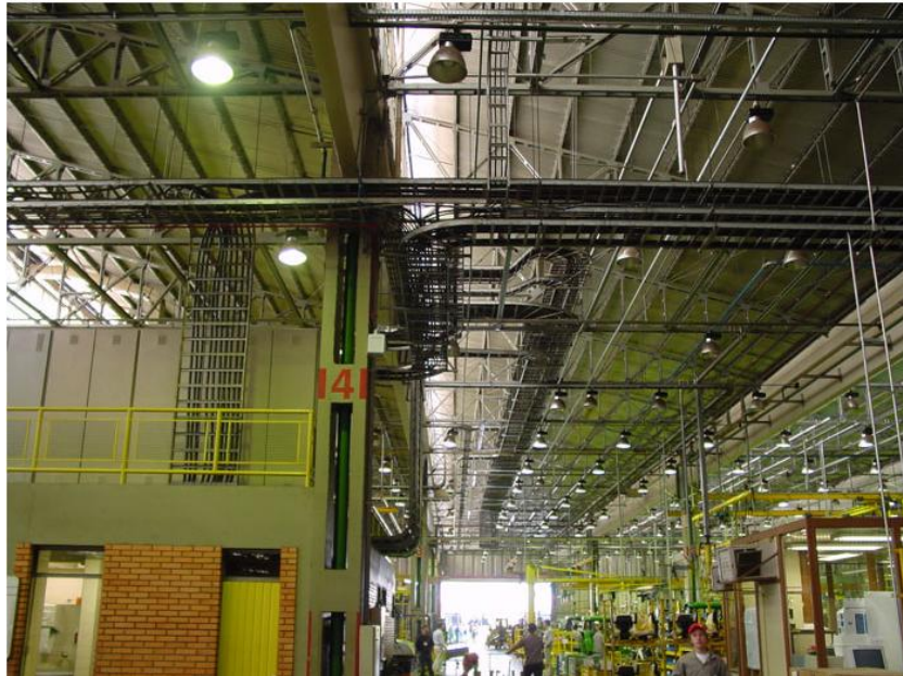
Figura 36 – Sheds de iluminação e ventilação
